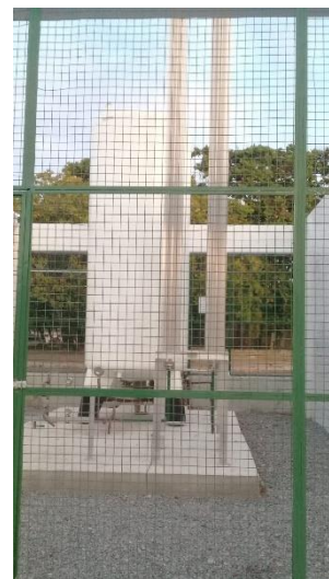
Instalação do Tanque de oxigênio
