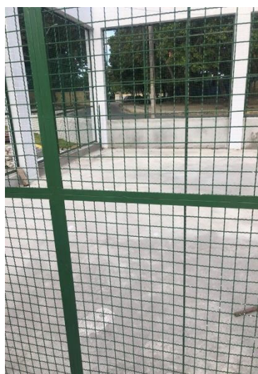
Antes da adequação
